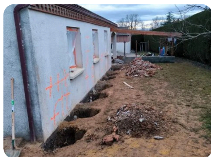
Fouilles sous les murs · cages de longrines sur micropieux · façade remise à neuf.
