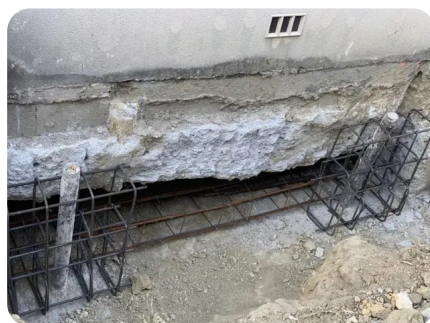
Fouilles sous les murs · cages de longrines sur micropieux · façade remise à neuf.
